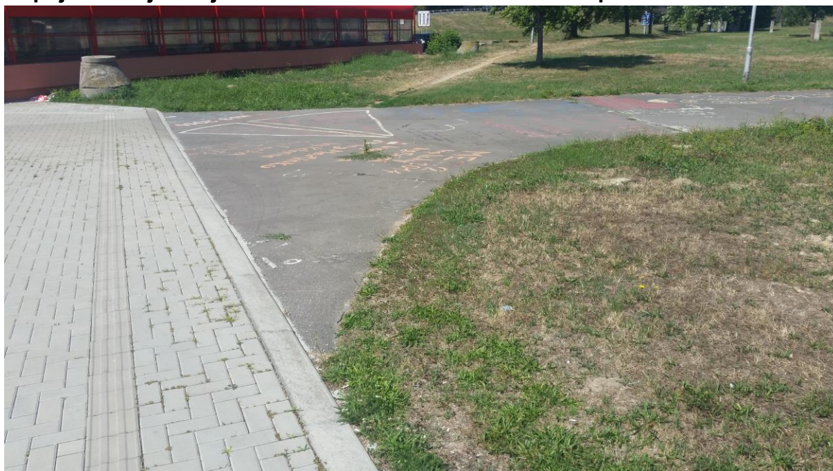
Napojenie na jestvujúcu už realizovanú zámkovú dlažbu pri MHD
