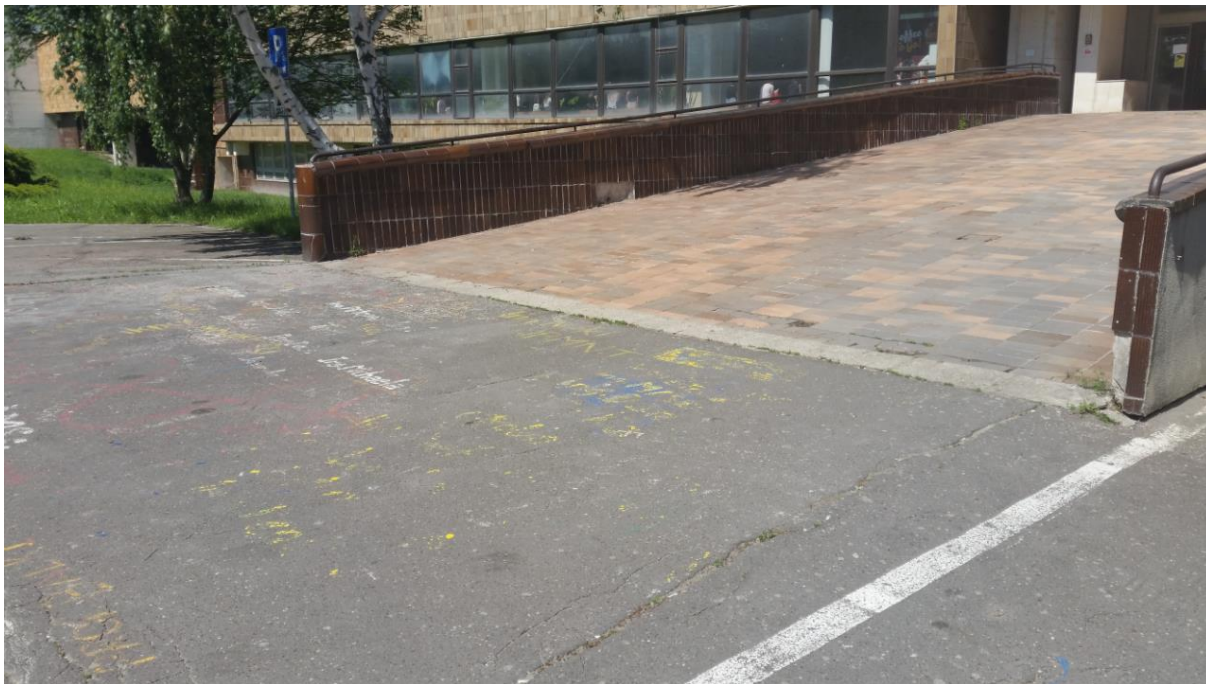
chodník pred rampou do budovy V1
