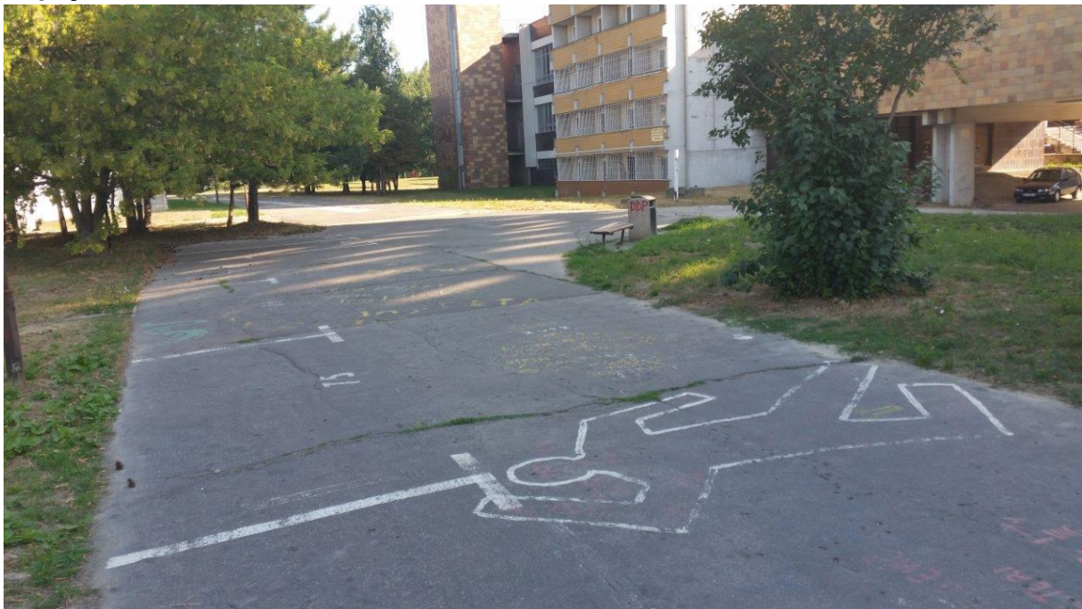
napojenie č.6 - miesto ukončenia rekonštrukcie chodníka
